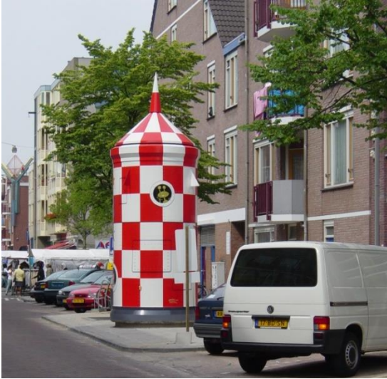
Betonnen zuil 1 Deur
