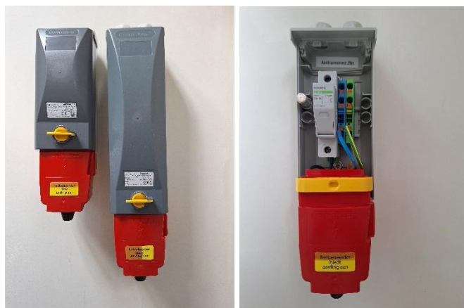
Foto 1, aansluitkasten OVL, (Links compacte OVL en rechts de voorloper, incl. foto van binnenwerk).
